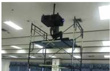
ภาพที่ 23 ติดตั้งเครื่องโปรเจคเตอร์ เพื่อปรับปรุงระบบภาพ ณ ห้องประชุมเอกทศร 9
